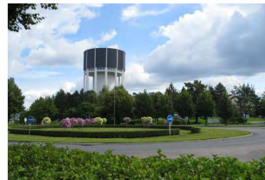
Kuva: Vesitorni on toiminut Lappeenrannan keskustan maamerkinä nykyisessä asussaan jo 1950-luvulta lähtien. Alkuperäinen, vuonna 1927 rakennettu vesisäiliö on säilynyt tornin sisällä.
